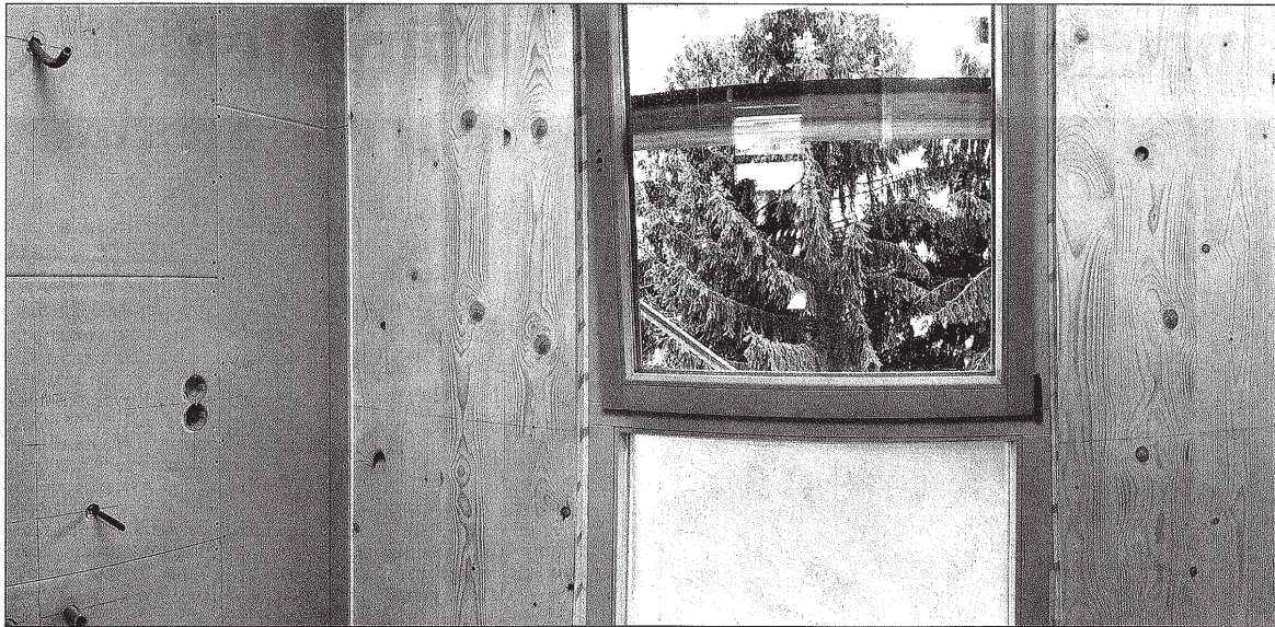
Herzstück der neuen Generation von Holzgebäuden sind großformatige Platten aus Brettspertholz.
