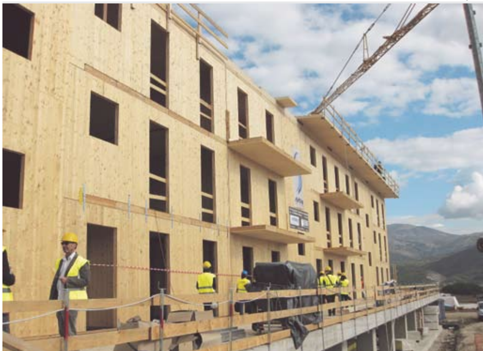
Brettsperrhölzer mit Längen von bis zu 16 Metern eignen sich für den mehrgeschossigen Bau
