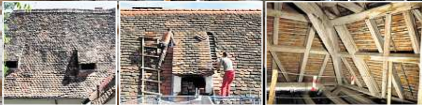
Langhaus des Grazer Doms, darunter von links: Typische Biberschwanzziegel unserer Dächer, Dachdeckerarbeiten am Palais Herberstein, Dachstuhl der Alten Universität
