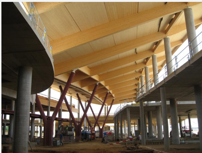
G3 Shopping Resort Gerasdorf (A) | Bauzustand (Einsatz von Brettsperrholz und Brettschichtholz) | Foto: TU Graz.
