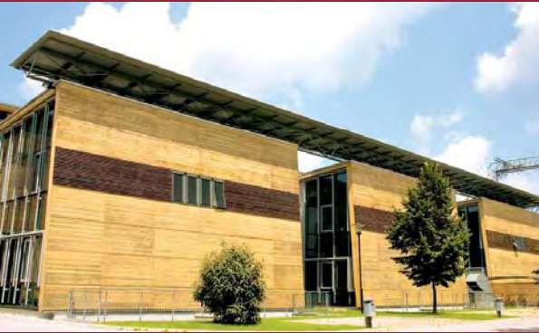
Das Kompetenzzentrum für Holzbau und Holztechnologie im Bautechnikzentrum der Technischen Universität Graz
